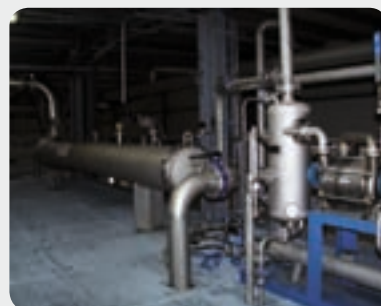
|DICHTUNGEN IN PRODUKTIONSANLAGE| ab Seite 5/5
